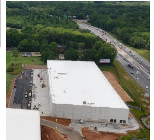
Bild: CarBatteryReFactory 2, Greenville
